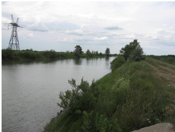
Рисунок 1 – Канал в земляном русле
