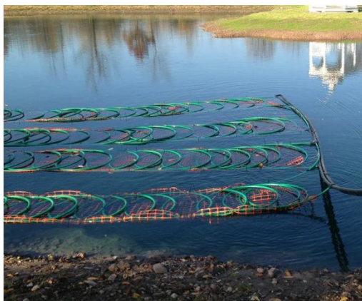
Рисунок 3 – Укладка ветки теплового контура в близлежащий водоем
